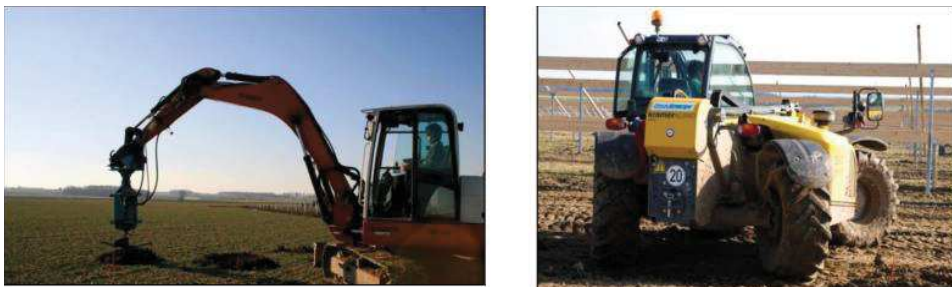
Illustration 22 : Exemple d'engins nécessaires sur le chantier
