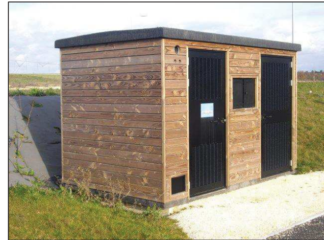
Illustration 19 : Exemple de poste de livraison
