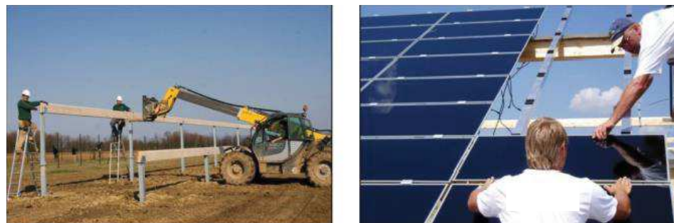
Illustration 23 : Montage des structures porteuses et des modules
