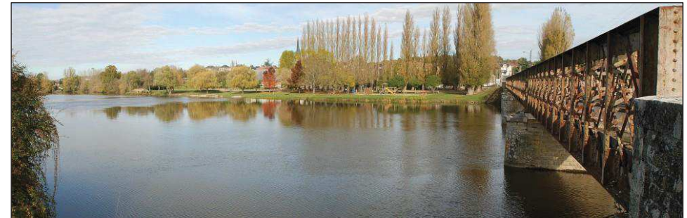
Illustration 96 : La vallée du Cher des confins de la Sologne – Châtre-sur-Cher (Source : : Agence Folléa-Gautier, paysagistes-urbanistes)
